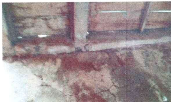
Foto 3: reconstruccion de piso
