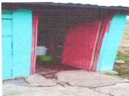
Foto 5: Sustrucción de puerta de madera por puerta de metal
