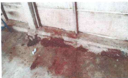
Foto 4: Sustrucción de tabla por block
