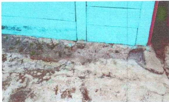
Foto 1: Sustrucción de tabla, por block
